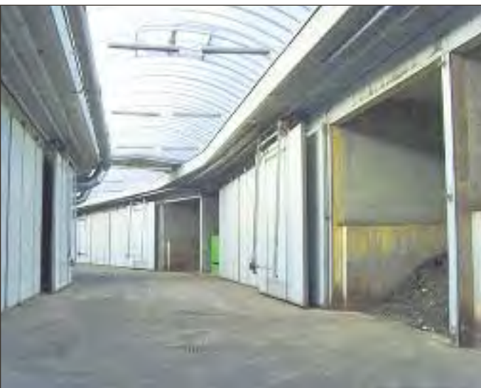
MBRA im Abfallbehandlungszentrum Wiewärthe Pößneck: Blick in die Fahrgasse mit den Rottetunneln
