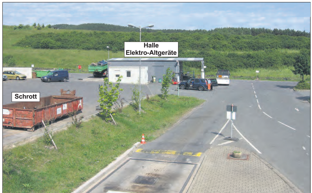
Blick auf den Wertstoffhof im ABZ Wiewärthe mit dem Container für Schrott im Vordergrund und der Halle für die Zwischenlagerung der Elektrogeräte
