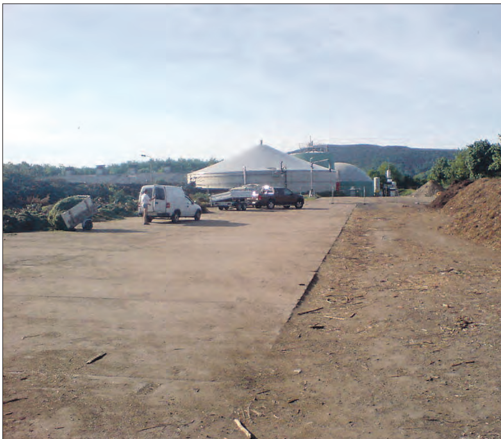
Neue Befestigung des Grünabfallannahmeplatzes Catharinau
